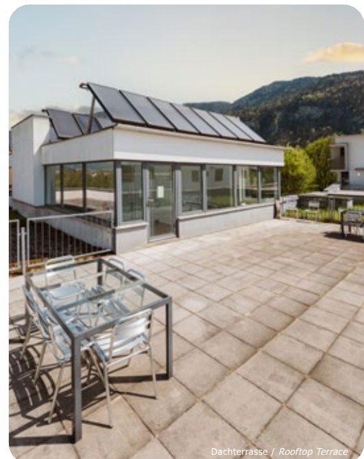
Dachterrasse / Rooftop Terrace
